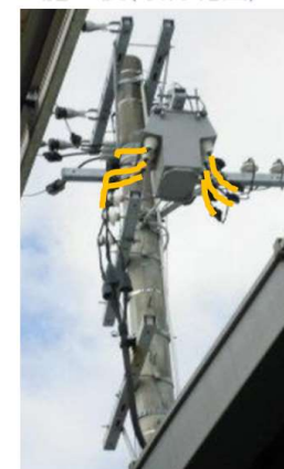
施工後(取付範囲)
